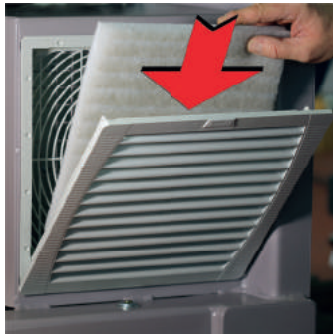
Filtermatte einlegen Filtermattenquerschnitt (dichtere Seite links)
