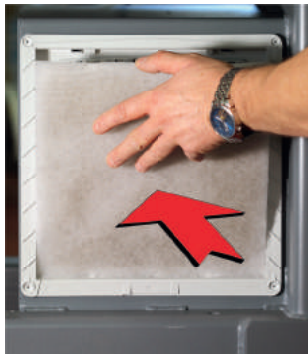
Filtermatte einlegen Filtermattenquerschnitt (dichtere Seite links)
